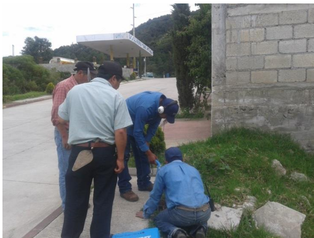
Foto: Trabajos de mantenimiento cabecera municipal.
