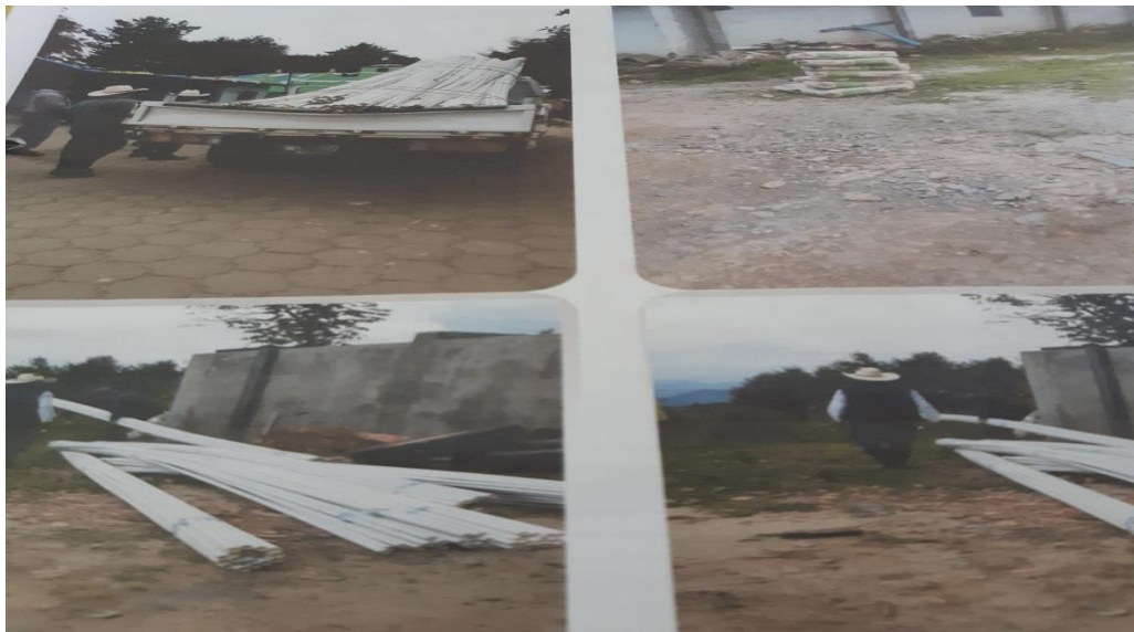
CONSERVACION CAMINO VECINAL CON ARRENDAMIENTO DE MAQUINARIA ALDEA LAS BARRANCAS, SAN ANTONIO SACATEPEQUEZ, SAN MARCOS.
