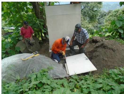
Foto: Construcción de letrinas.
